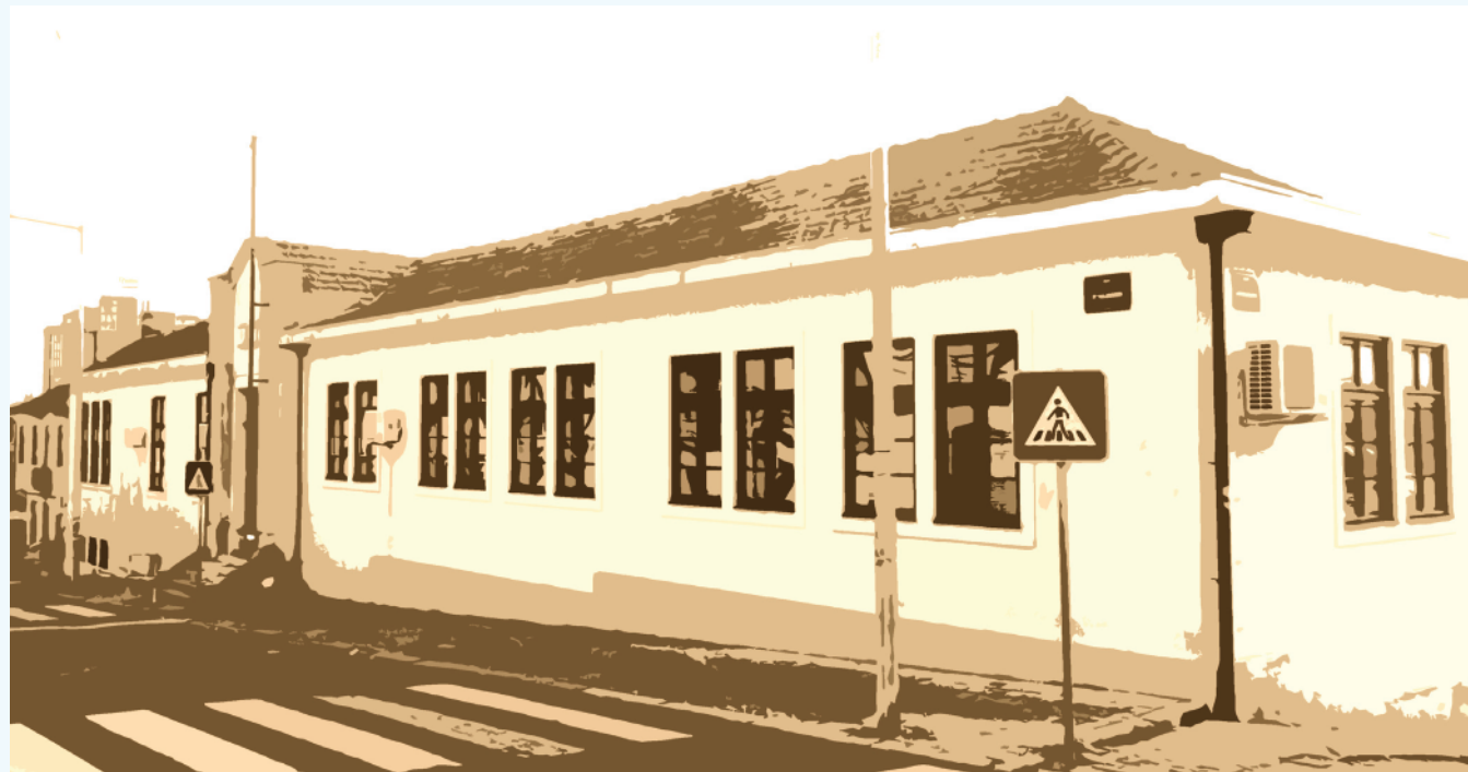
Edifício II (antigas instalações da ESEnfCVPOA)
